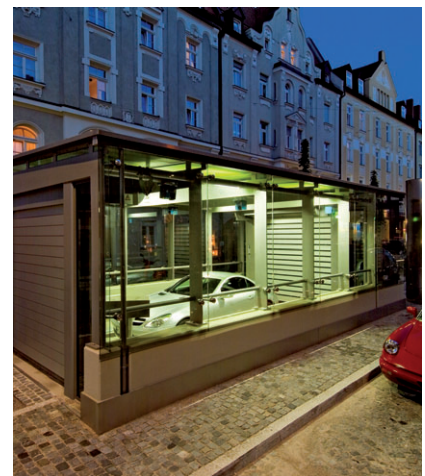
Sobald die Parkpalette mit Pkw den Übergabebereich erreicht, wird dieser für ca. 2 Minuten hell erleuchtet, um der Fahrerin ein Gefühl der Sicherheit zu geben.
