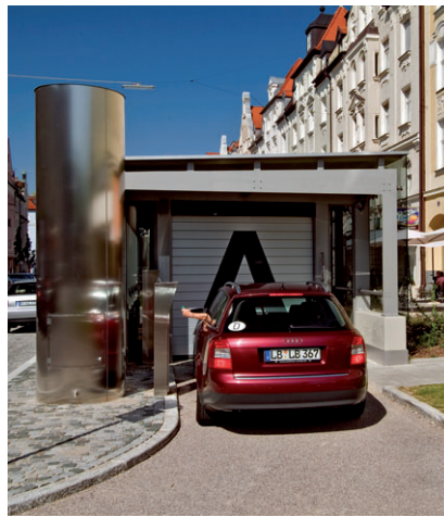
Die Übergabebereiche (A, B, C und D) sind direkt von der Straße aus befahrbar. In der Zufahrt wählt der Fahrer berührungslos durch Transponderchip seinen Einparkvorgang an.
