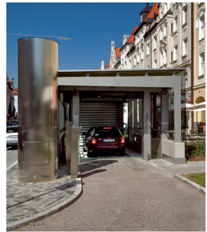
Dann öffnet sich das Tor automatisch, der Fahrer wird beim Einparken durch Hinweise auf einer Großtextanzeige geleitet.
